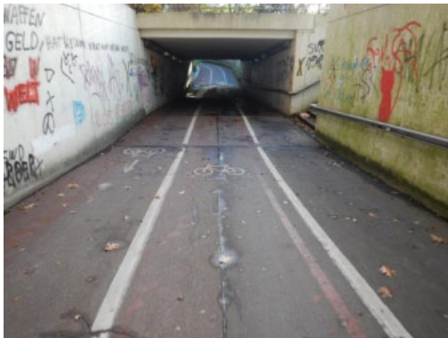
Bild 7: Fußgänger- und Radfahrer Unterführung
