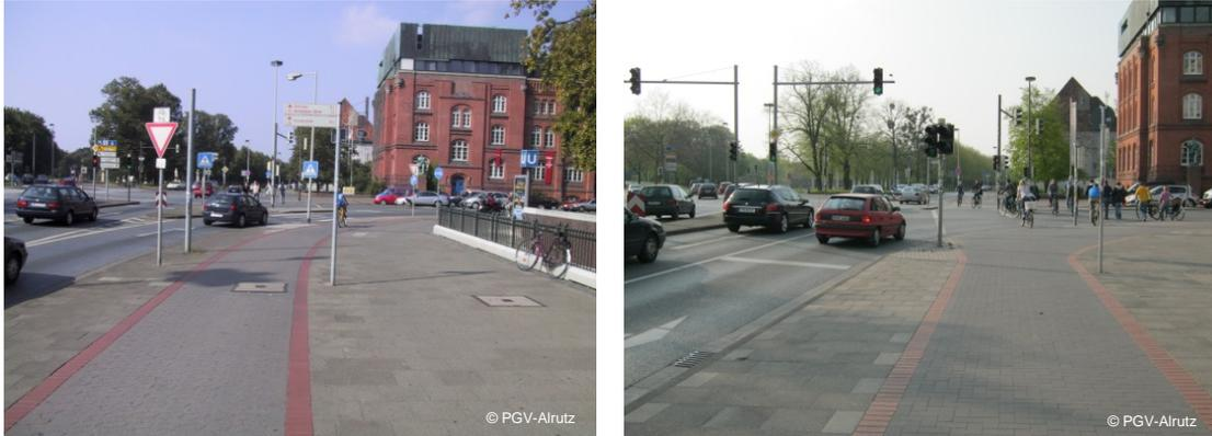
Abb. 4-19: Rückbau und Signalisierung eines konflikträchtigen freien Rechtsabbiegefahrstreifens in Hannover (links vorher, rechts nachher)
