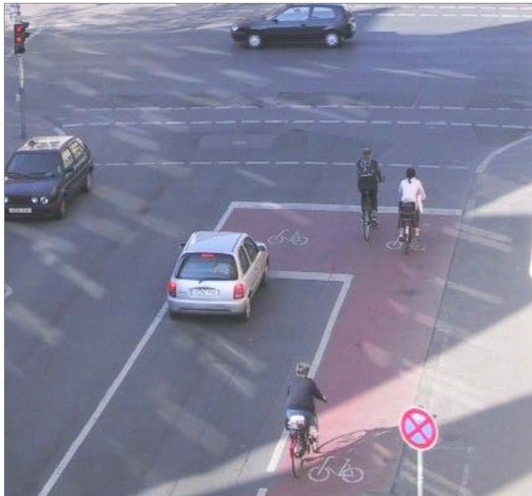
Abb. 4-20: Aufgeweiteter Radaufstellstreifen (ARAS) (Hannover)
