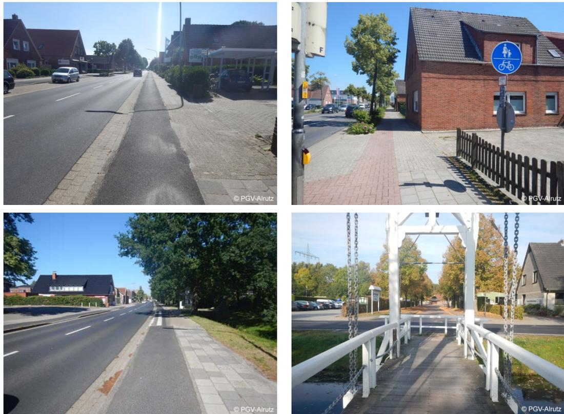
Abb. 4-26: Ungesicherte, abgesenkte Grundstückszufahrten (oben links), gemeinsame Führung mit dem Fußverkehr, farblich angesetztes Pflaster (oben rechts), Führung des Radverkehrs durch Bushaltewartfläche (unten links), für den Radverkehr ungeeignete Kanalbrücke (unten rechts)
