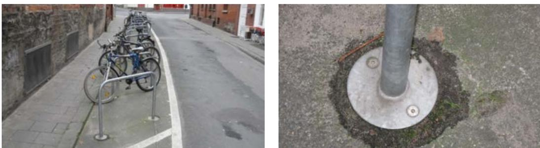
Abb. 5-4: Beispiele für verschraubte Rahmenhalter (Lüneburg)
