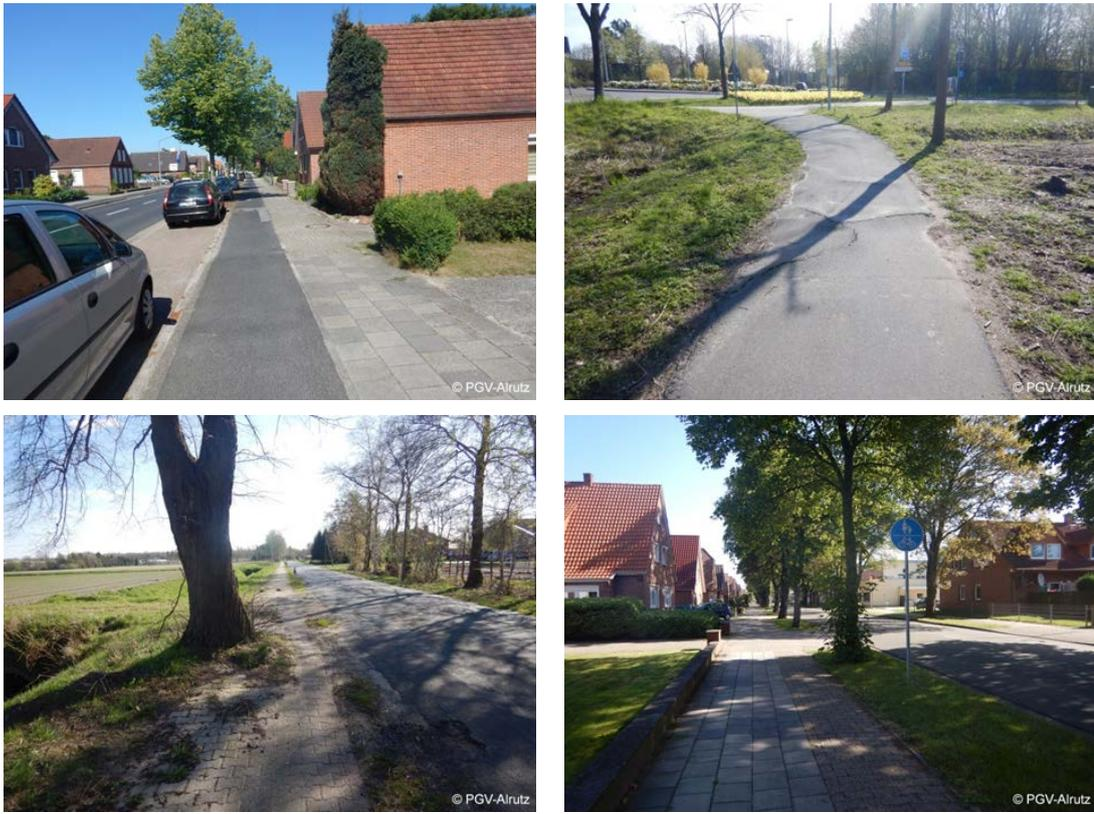
Abb. 4-23: Mängel an baulichen Radwegen: unzureichende Breite und fehlender Sicherheitstrennstreifen (oben links), Belagsschäden (oben rechts), Zweirichtungsverkehr mit Benutzungspflicht in unzureichender Breite (unten)
