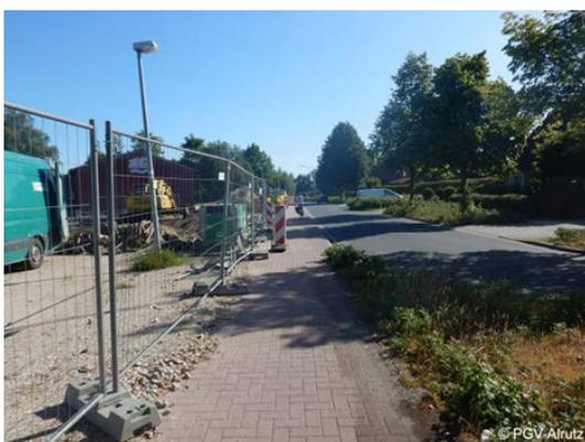
Abb. 4-31: Fehlende Berücksichtigung des Radverkehrs an Baustelle im Hümmlinger Weg (Gehweg, Radverkehr frei im Zweirichtungsverkehr)
