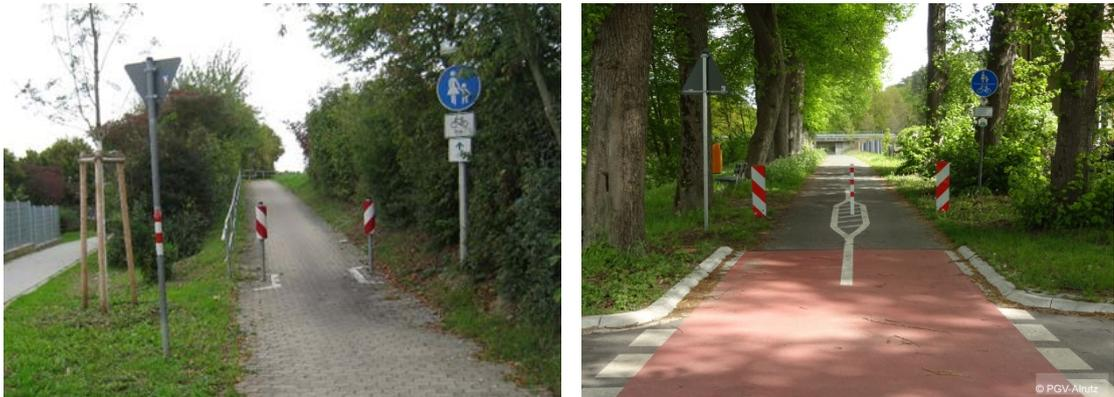
Abb. 4-30: Beispiele für Poller mit Bodenmarkierungen in Bruchsal (links) und Nordhorn (rechts)
