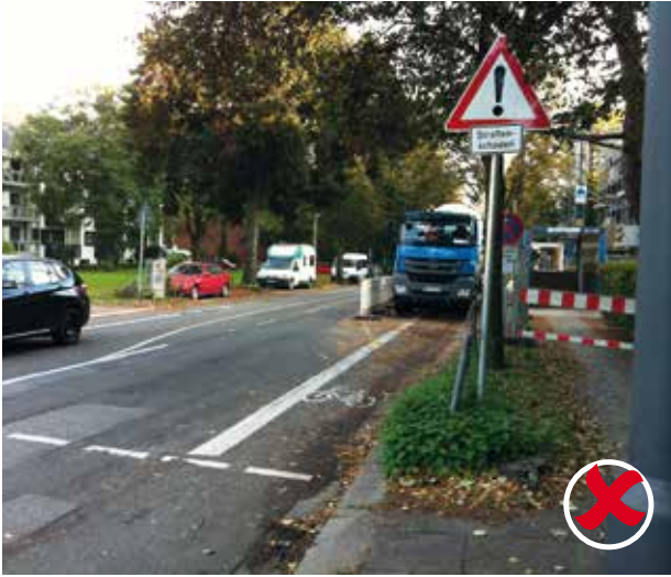
Bild 14 | Arbeitsstelle auf Radfahrstreifen ohne Absicherung
