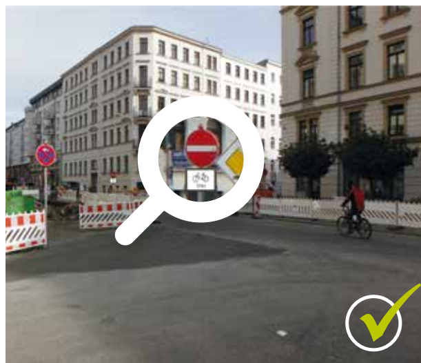
Bild 2 | Arbeitsstellenbedingte Einbahnstraße für Radverkehr freigegeben
