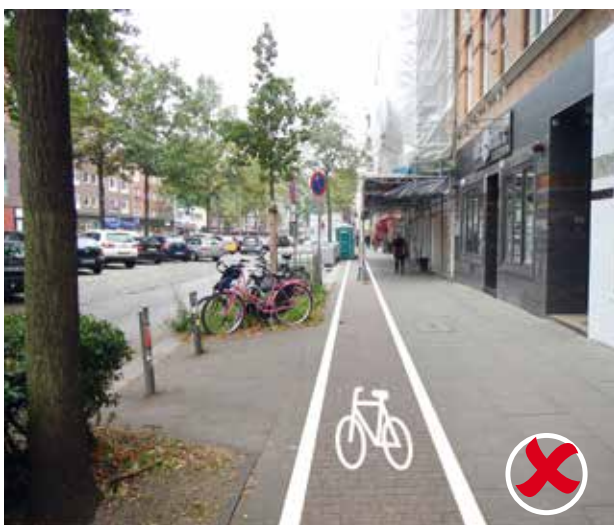
Bild 12 | Gerüst auf Radweg mit schlecht sichtbarer Sicherung
