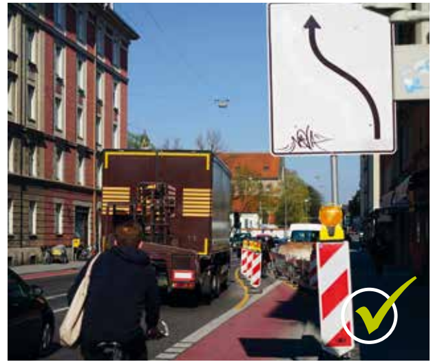
Bild 15 | Arbeitsstelle auf Radfahrstreifen durch Absperrung gesichert
