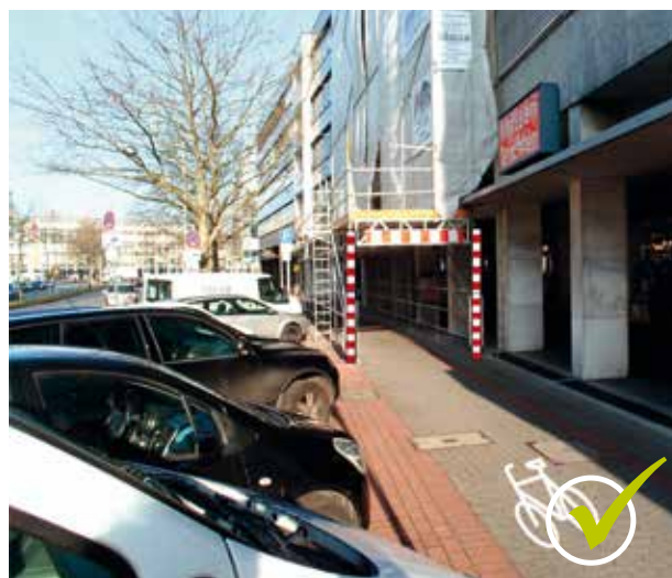
Bild 13 | Gerüst ausreichend gesichert (Anmerkung: Gehweg befindet sich unter den Arkaden)
