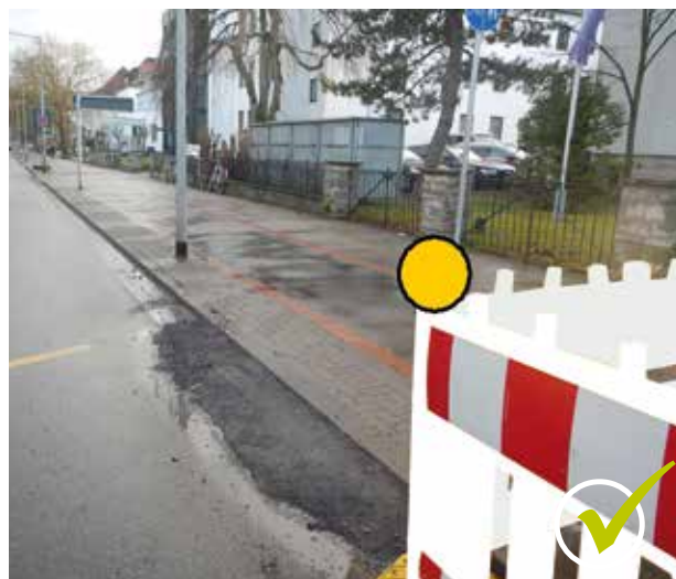
Bild 7 | Anrampung in Form von Asphaltkeil hergestellt
